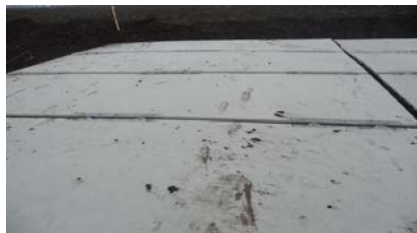
Вариант раскладки матов КДМ для площадок, колеyjnych проездов гусеничной и колесной техники, жилых городков.
