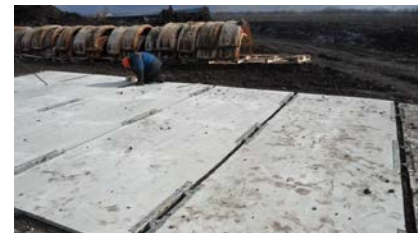
Вариант раскладки матов КДМ для организации проездов колесной и гусеничной техники массой до 100 тонн, обустройства
