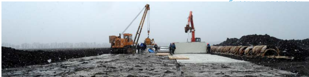
Вариант раскладки матов КДМ для площадок, колеyjnych проездов гусеничной и колесной техники, жилых городков.
