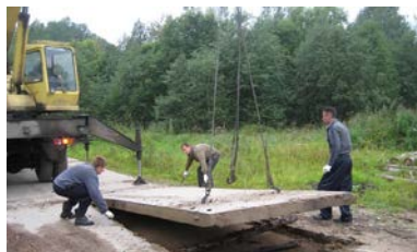
Отсыпка песчаного основания с покрытием из железобетонных плит
