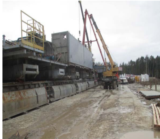
УСТРОЙСТВО ТВЕРДОГО ОСНОВАНИЯ ИЗ ПЛИТ ДЛЯ РАССТАНОВКИ И ПЕРЕДВИЖЕНИЯ КРАНОВОЙ ТЕХНИКИ ВДОЛЬ ЭШЕЛОНА БУРОВОЙ УСТАНОВКИ.
