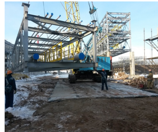
УСТАНОВКА САМОХОДНОГО ГУСЕНИЧНОГО КРАНА СКГ-631 (83 ТН) НА ТВЕРДОЕ ОСНОВАНИЕ ИЗ ПЛИТ. МОНТАЖ ЭСТАКАДЫ (22 ТН).
